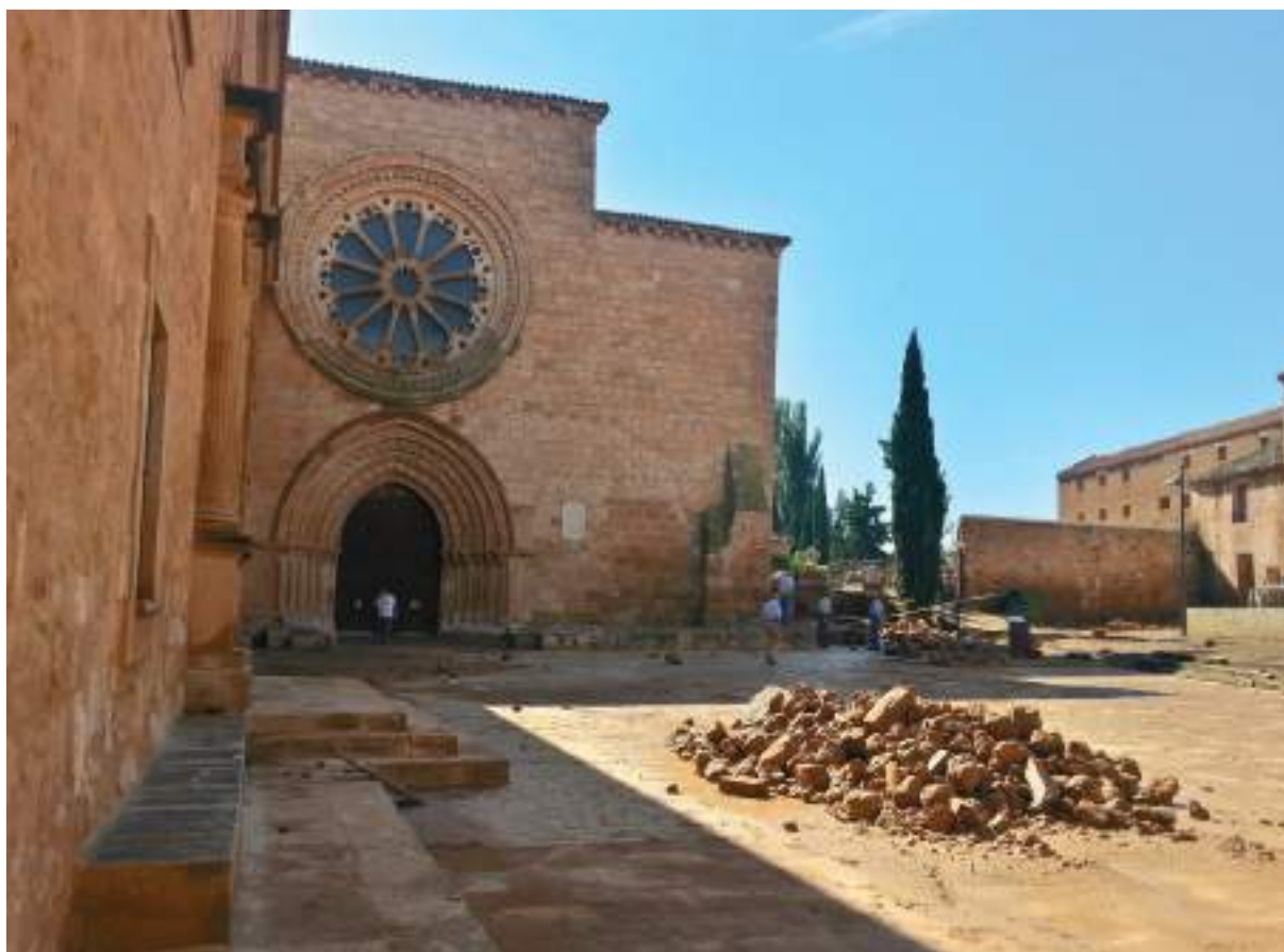
Derrumbe del cerramiento del monasterio de Santa María de Huerta como consecuencia de la inundación de junio de 2015. Foto: Junta de Castilla y León
