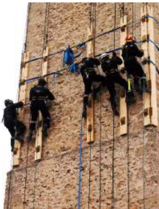
Trabajos de zinchado de la Torre Mangana. I Curso de intervención en protección del patrimonio histórico en emergencias. Cuenca 2014. Foto: UEGR
